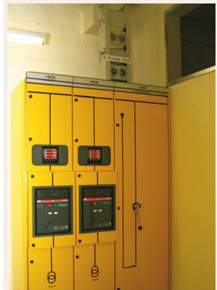
Hier wird die Energie der Fotovoltaikanlage via EWB ins Netz der BKW eingespiesen
