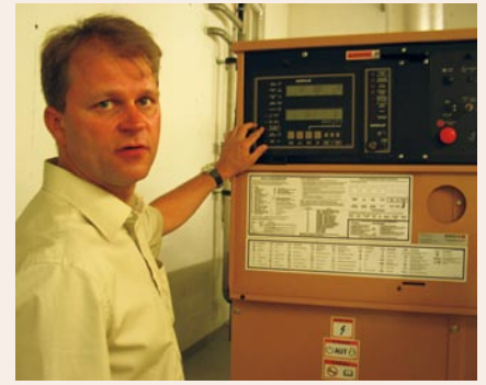
Links: Der Notstromdiesel mit 0,7 MW Nutzleistung sichert vor allem die Fortsetzung des Spielbetriebs und die Versorgung der Medien. Rechts: Extra für das Bulletin startete Daniel Vetter einen Testlauf des Generators: Nach 17 Sekunden setzte die Stromproduktion ein. Der Elektroingenieur Daniel Vetter leitet ein Team von 4 Spezialisten, das für den Unterhalt der Energieversorgungs- und IT-Anlagen im Wankdorf-Center besorgt ist (2 Elektromonteur, 1 Mechaniker sowie 1 Gebäudetechnik-Spezialist).
