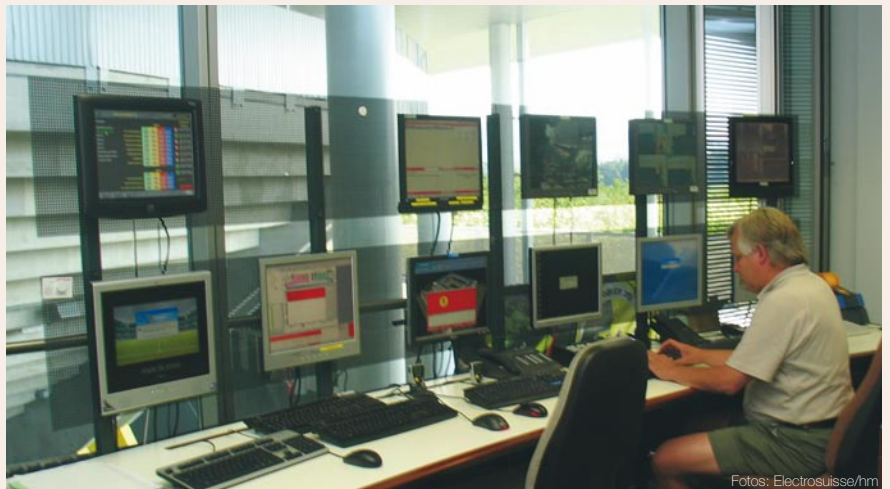
In der Kommandozone der MIB AG laufen alle Fäden des Wankdorf-Centers zusammen. Es besteht ein 24-Stunden-Pikettdienst; die Alarmierung erfolgt automatisch auf Pager.
